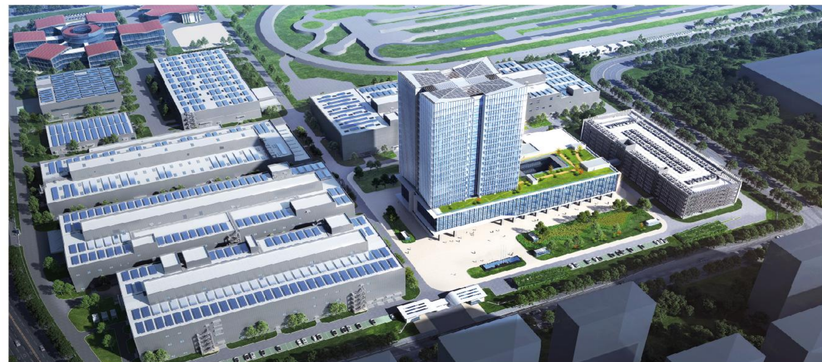
大众汽车（中国）科技有限公司三期项目
